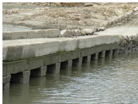
Detalle del Puente La Villa
