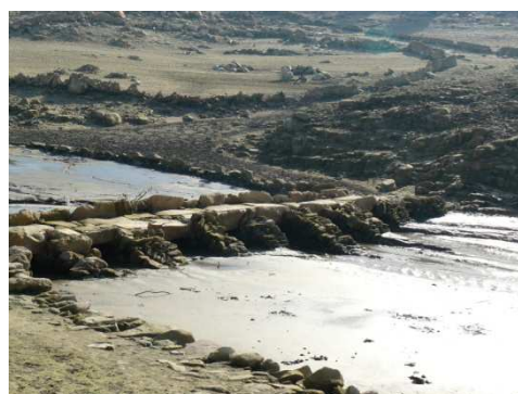
Puente Camino Salamanca
